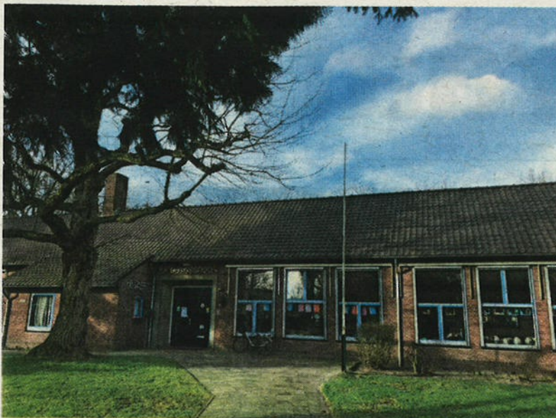
▲ Basisschool De Vaert is toe aan een opknapbeurt. FOTO BS DE VAERT
